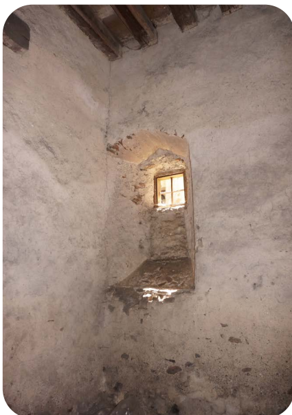
Abb. 5: Erdgeschoss des Turmes mit einem sekundär veränderten Fenster mit Dreieckssturz (Quelle: Claudia Theune 2020)
