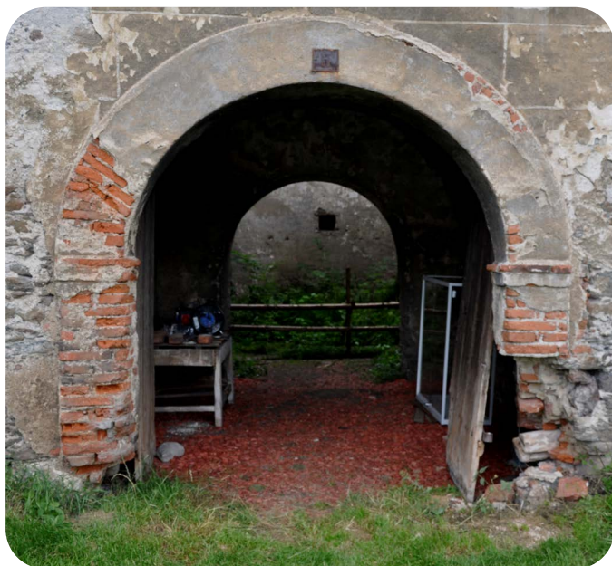
Abb. 12 a + b: Schlosstor vor und nach der Rekonstruktion der Laibung (Quelle: Robert Fürhacker 2015 und 2020)
